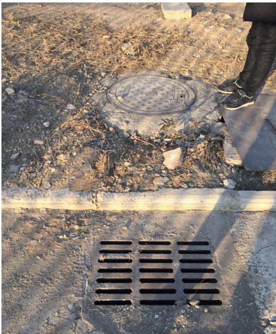
厂区内部排水沟、雨水口、集水井现状照片
